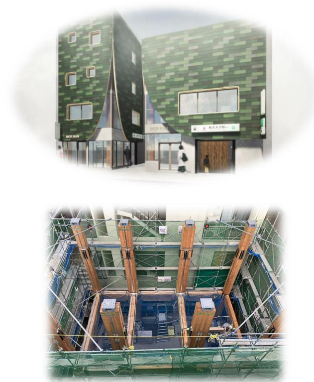
東急 駒沢大学駅西口ビル 長野県産唐松集成材 建方状況
