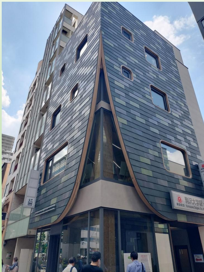
「Green UNDER GROUND」プロジェクト 駒沢大学駅西口ビル
